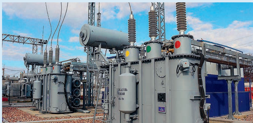
Трансформаторы с высоковольтными вводами «Изолятор» на подстанции 110 кВ «Аянская» в Симферопольском районе (фото: ГУП РК «Крымэнерго»)
