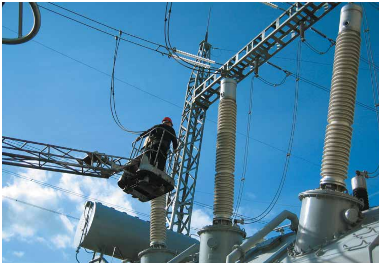
Подготовка к испытаниям вводов «Изолятор» 330 кВ в Латвии
