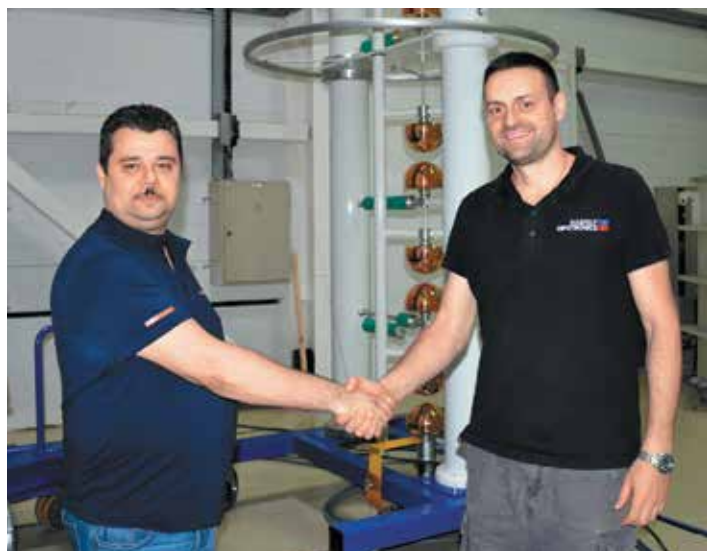
Установка и запуск генератора в эксплуатацию завершились успешно!
