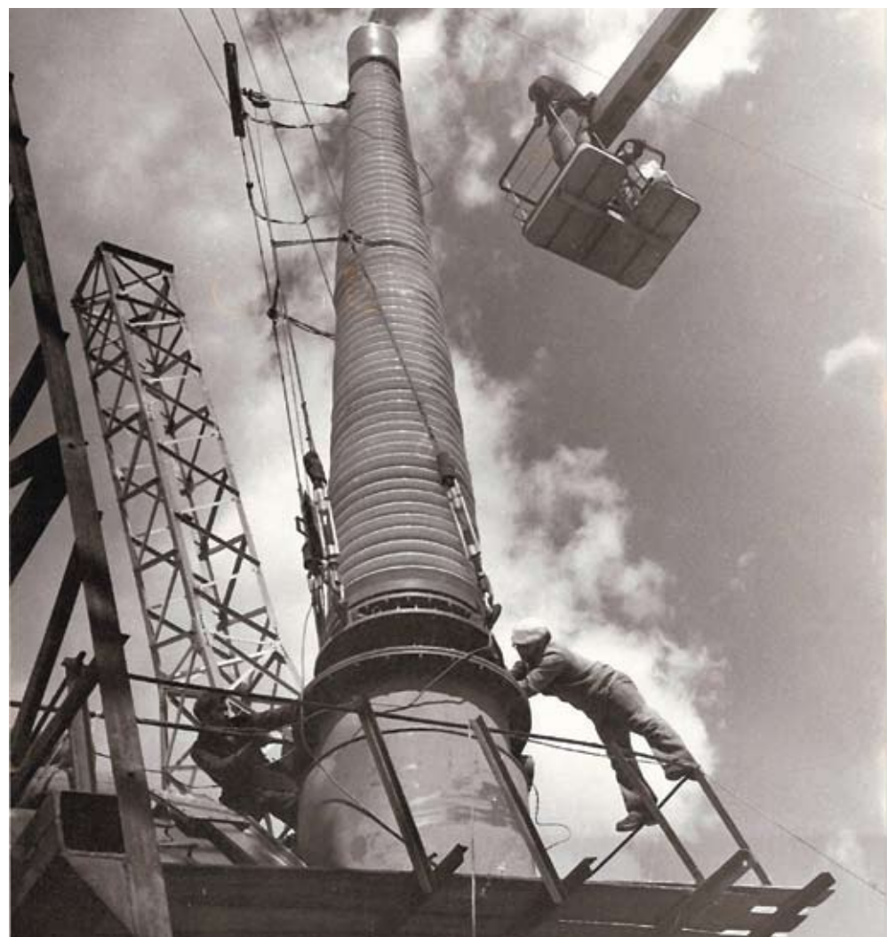
Монтаж вводов 1150 кВ на ЛЭП «Экибастуз — Кокчетав» в Казахстане
