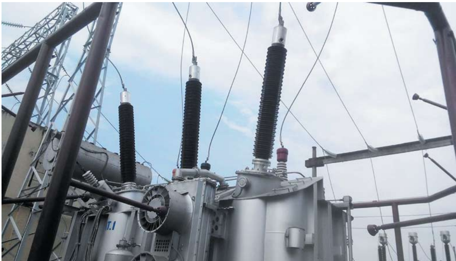
Вводы «Изолятор» с RIP-изоляцией 220 кВ на трансформаторе ГЭС Хоабинь (Вьетнам)
